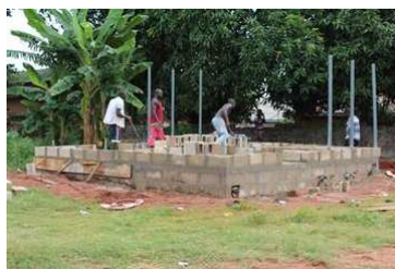
Er wordt hard gewerkt aan het nieuwe toiletgebouw.
