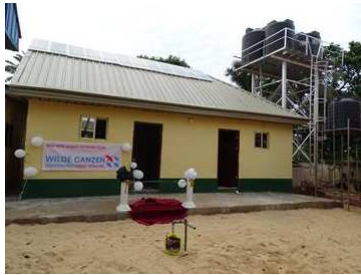
Het toiletgebouw bij Obioma school is klaar!
