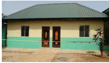
Het nieuwe toiletgebouw
