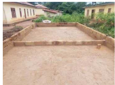
Het fundament is klaar
