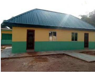
Nieuw toiletgebouw Ebenator
