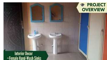
Een kijkje in het toiletgebouw
