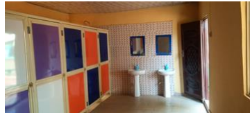
Een kijkje in het nieuwe toiletgebouw
