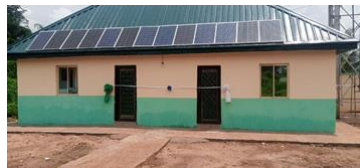
Het nieuwe toiletgebouw met de zonnepanelen
