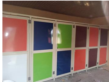
Een kijkje bij het damestoilet
