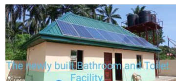
Het nieuwe toiletgebouw
