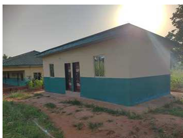
Het Ukwulu PHC nieuwe toiletgebouw!
