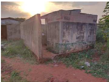
Het huidige toiletgebouw
