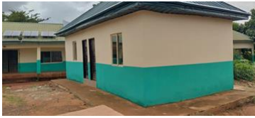
Nteje PHC nieuwe toiletgebouw
